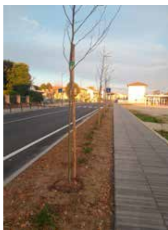
Dall'alto Lavori a Biancade
